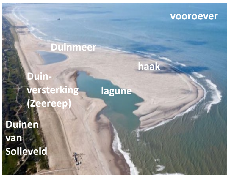
Figuur 1.1 Zandmotor na aanleg in 2011 (Rijkswaterstaat / Joop van Houdt)
