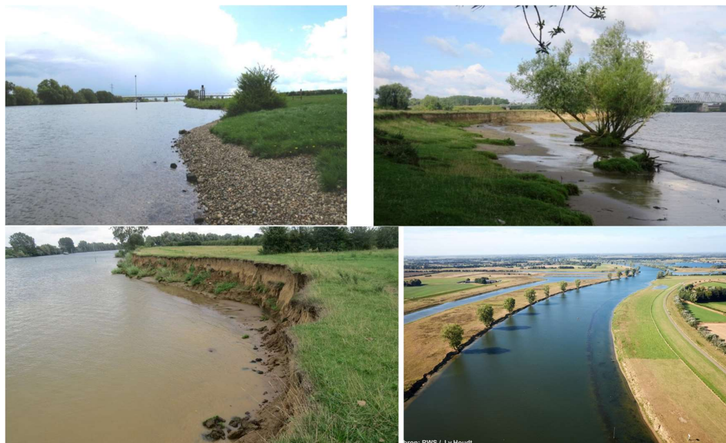
Figuur 2.7 Oevertypen: vastgelegd (links -boven), spontaan eroderend (rechts boven), natuurlijk (links onder) en natuurvriendelijk met onderwaterdam (rechts onder).
