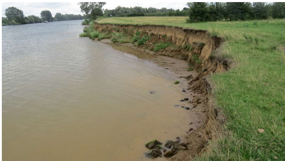
Figuur 1.3 Natuurlijke oever Oeffelt. De oeverbestorting is hier over een lengte van 1.3km verwijderd.
